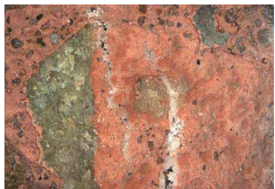
BETOCRETE-C17 (BV) in eingefärbtem Beton nach 21 Tagen Wasserlagerung
