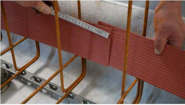
Stöße mindestens **50mm** überlappen und mit Verbindungsklammer sichern
