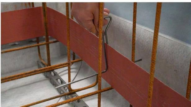
ROBOFLEX-FB auf Oberarmierung positionieren und Montagebügel anbringen
