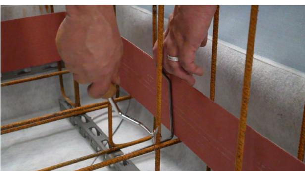
Fixieren der Montagebügel mit Bindedraht
