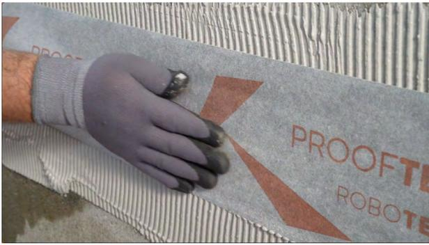
Dichtband in den frischen Kleber einlegen
