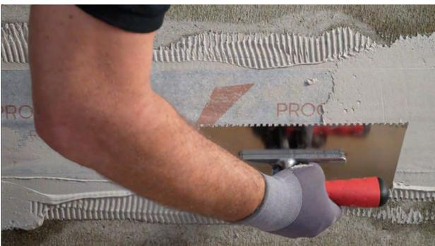
Das Dichtband wird mit einer zweiten Schicht MINTEC-2K Kleber dünn überzogen
