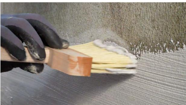
Die Randzonen werden nun in MINTEC-RS eingebettet und das ganze Dichtband mit dem Spezialpinsel überstrichen, so dass die Randzonen kaum mehr sichtbar sind und eine gute Optik erhalten.
